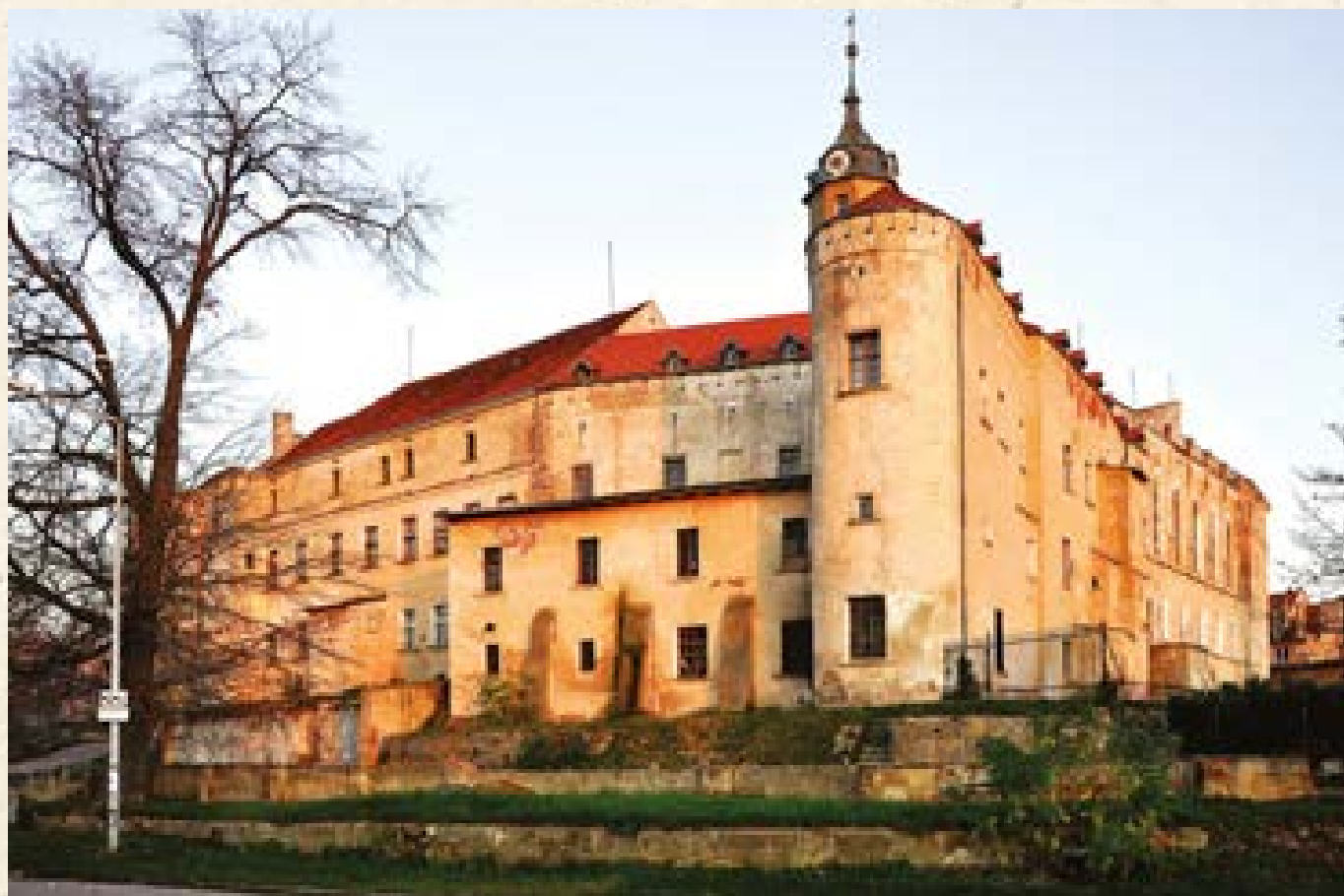
▲ Zamek w Jaworze przeszedł w ciągu wieków wiele przebudów. Widok dzisiejszy
