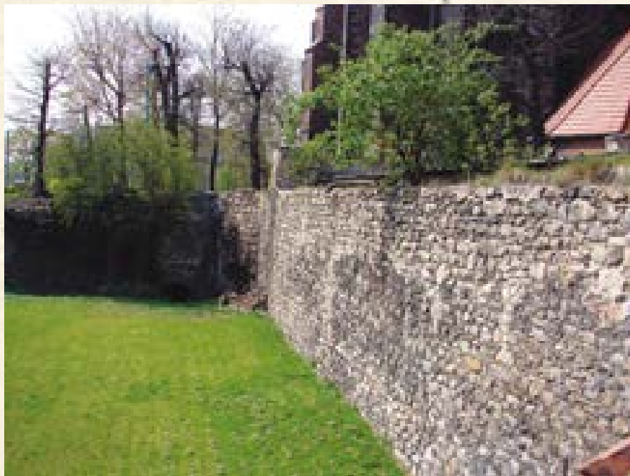
▲ Zachowane mury obronne wzdłuż al. Niepodległości w Świdnicy
