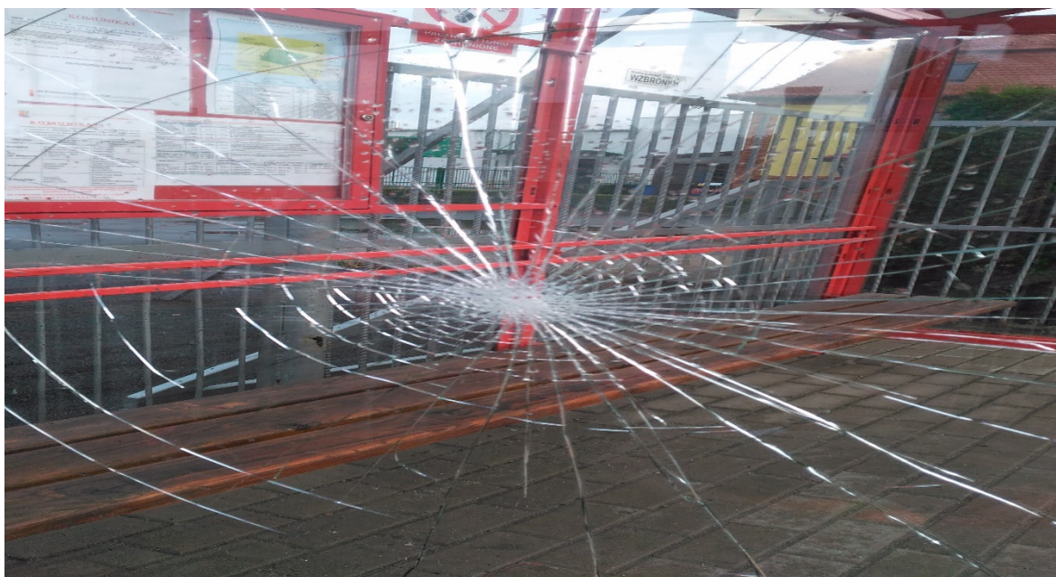
Wiata przy ul. Bystrzyckiej
